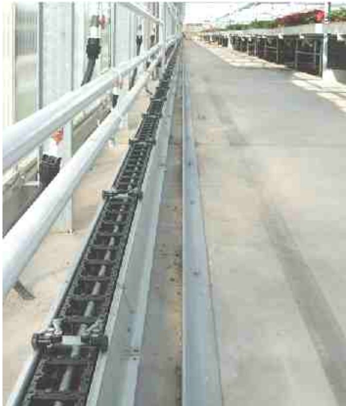
Anwendungsbeispiel Gewächshaus: Relative Luftfeuchtigkeit 80-100% Verfahrweg 150 m
